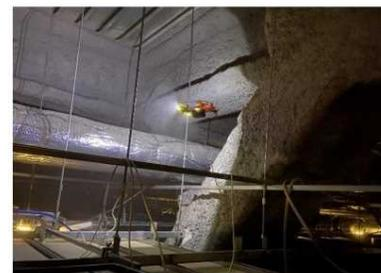
大型商業施設のリニューアル工事にともない、人が進入できない天井裏の様子をドローンで確認。形状や損傷具合、資機材の有無などを調査した。
