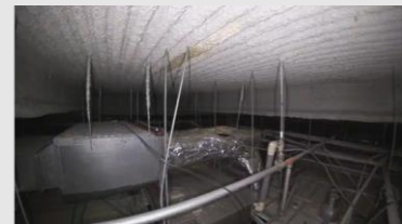
天井裏内部 (IBIS2撮影映像より抜粋)
